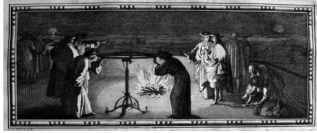
Mesures géodésiques de nuit pour la mesure de la terre au 17e siècle (gravure signée «S. Le Clerc in. E f.»). In : PICARD, Jean. La Mesure de la Terre . - Paris : Imprimerie royale, 1671. © Observatoire de Paris
